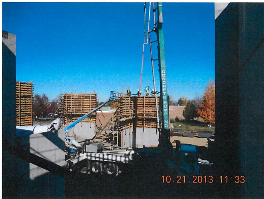
Final Structural Wall Pour
