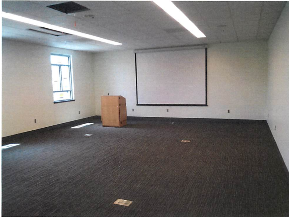
AV lectern installations proceeding – all classrooms
